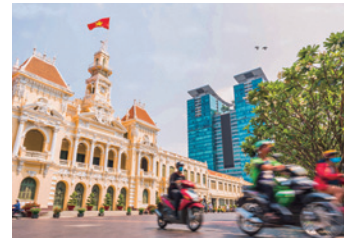
ホーチミン市庁舎
